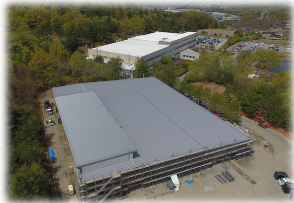
新建屋 上空より 建屋:約2,600㎡ 2025年4月 撮影
