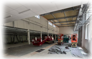
新建屋 屋内（工事状況）
